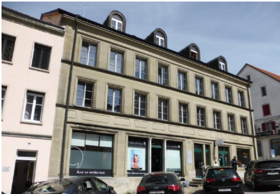
Façade principale du bâtiment depuis la rue des Moines
