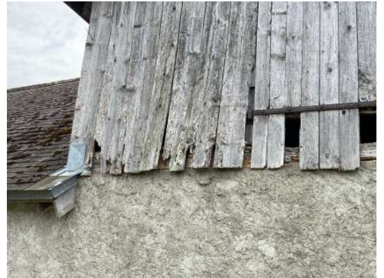
Lames bois pont de grange façade N.O
