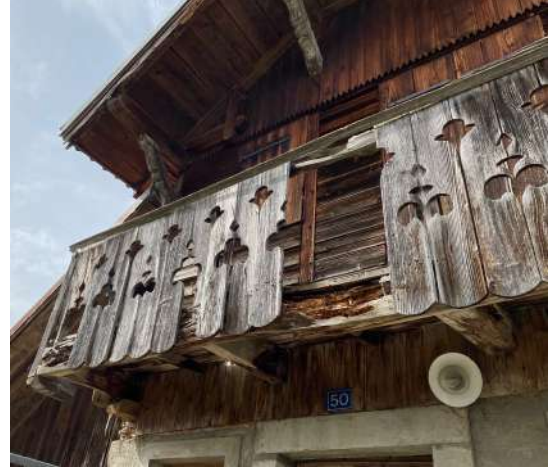
Balcon et garde-corps
