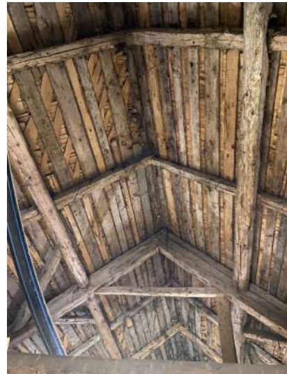
Etat général de la charpente
