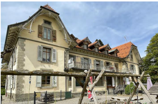
Humilimont 30 – Crèche et 1 logement
