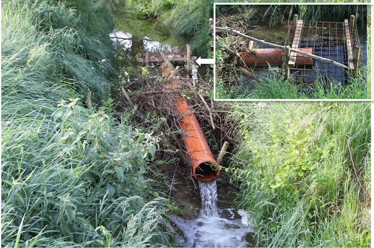
Image 1 : Aménagement d'un écoulement artificiel dans un barrage de castor. L'écoulement doit être protégé par un grillage, sinon le castor risque de le boucher (photo : SFF).
