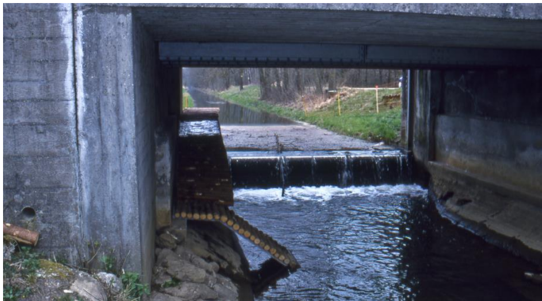
Image 7 : Cette rampe permet au castor de franchir le seuil sans être forcé de traverser la route très fréquentée située au dessus. Avant l'installation de la rampe, 5 castors sont morts écrasés. Depuis, plus aucun cas n'a été observé. Le seuil n'existe plus aujourd'hui et la rampe a pu être enlevée (Angst 2009).
