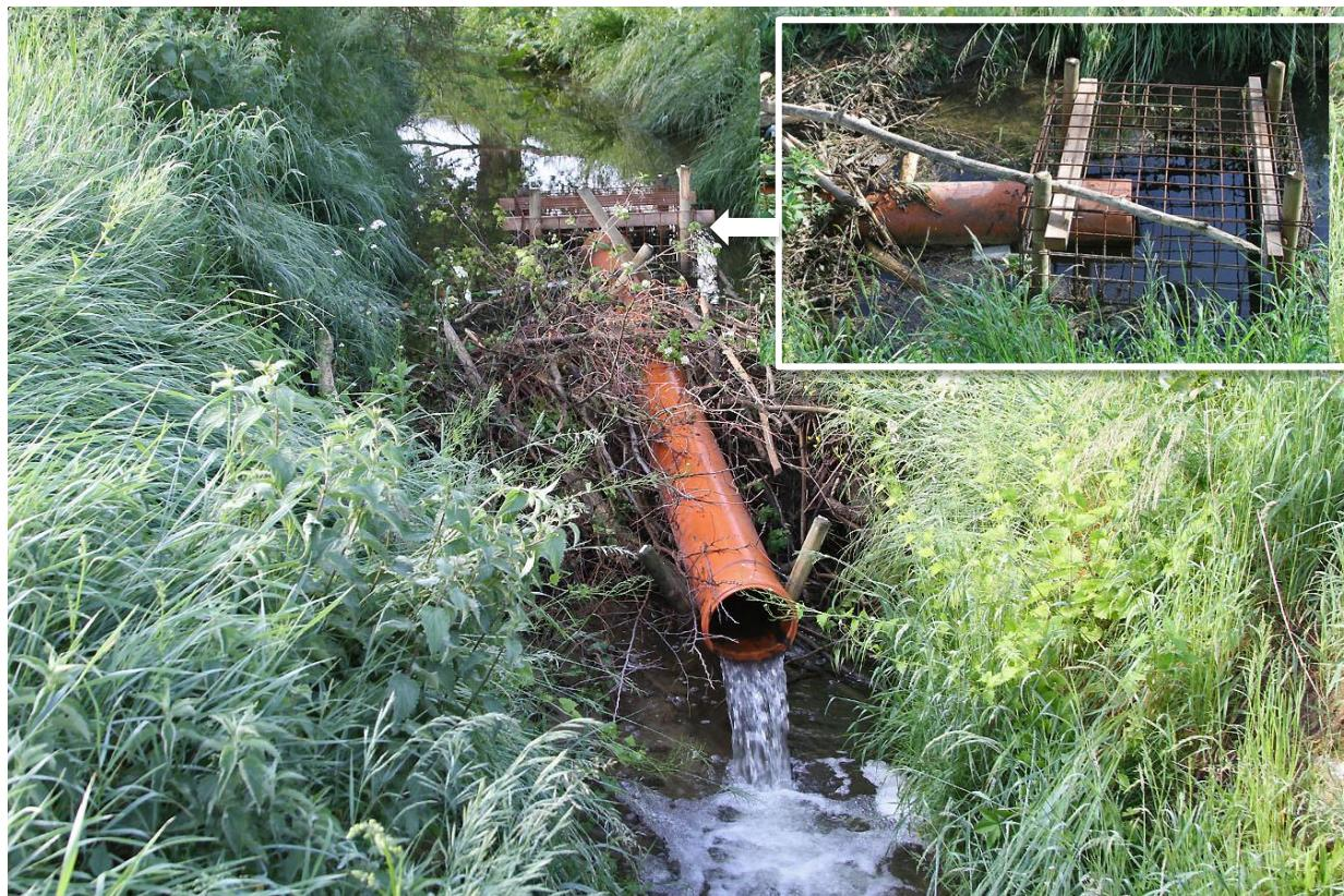
**Bild 1:** Ein durch einen Biberdamm gelegtes Rohr ermöglicht den normalen Wasserabfluss. Ein Gitter rund um die Eingangsöffnung verhindert, dass der Biber die Öffnung verstopft. (Foto: WaldA).
