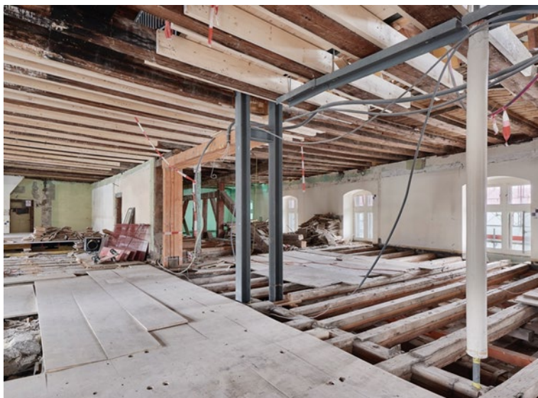
2 e étage : renforcements des structures des planchers au 2 e étage
