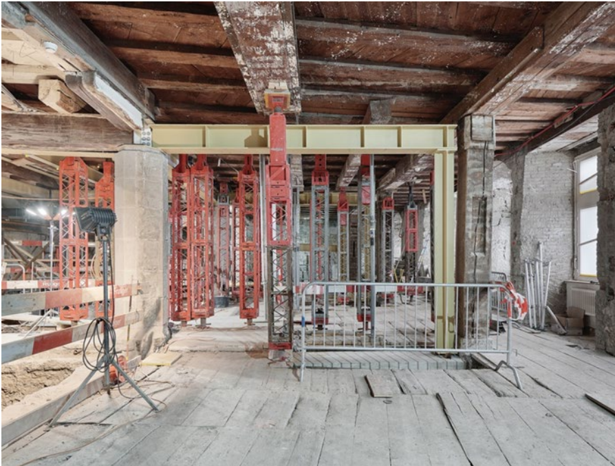
pose des éléments métalliques de renfort au rez-de-chaussée
