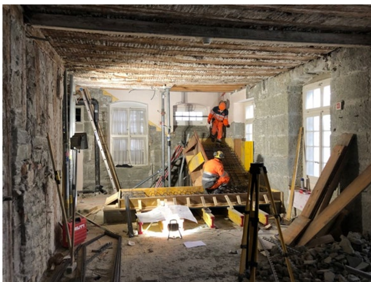
coffrage de l'escalier du corps-de-garde (photo AAE architectes)
