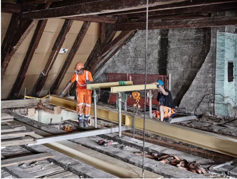
pose d'éléments de renforts métalliques dans les combles
