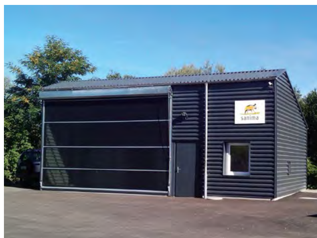
Centre collecteur de Châtillon / Sammelstelle von Châtillon
