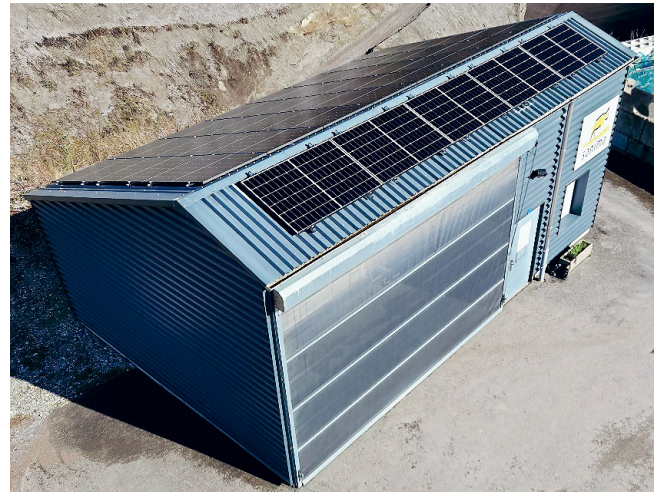
Centre collecteur de Châtillon Sammelstelle von Châtillon
