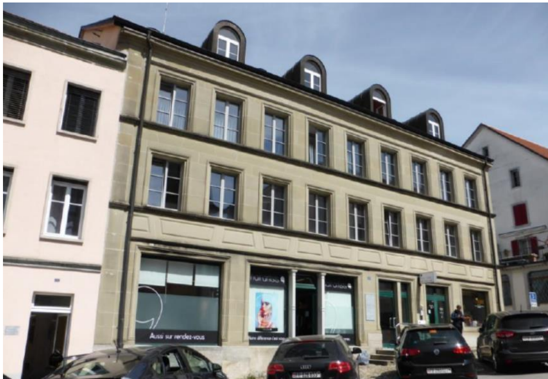
Hauptfassade des Gebäudes von der Rue des Moines aus
