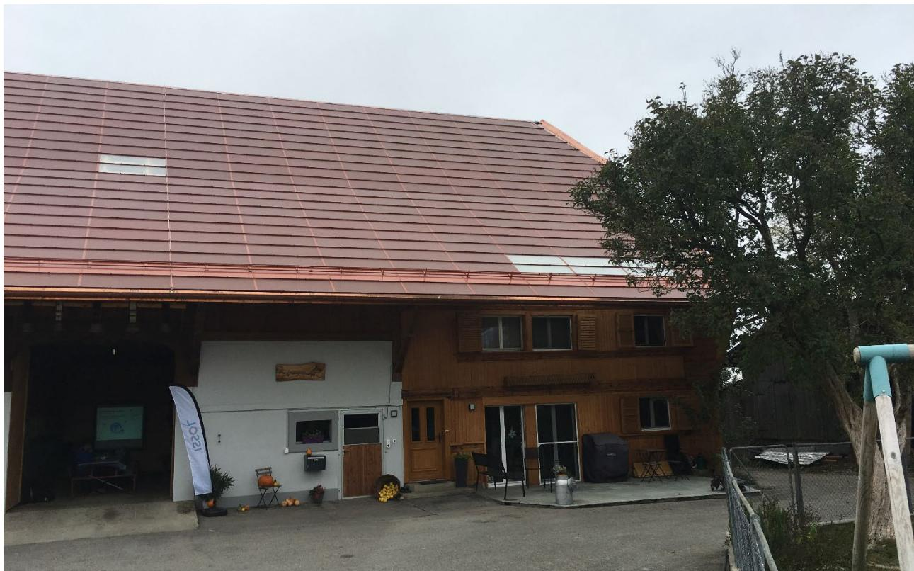
Bildlegende: Bauernhof in Ecuvillens, Standort von regionaler Bedeutung innerhalb eines zu schützenden Perimeters der Kategorie 2 im Sinne des kantonalen Richtplans. Pilotprojekt mit der Installation von ziegelroten Solarmodulen auf dem Dach des Bauernhofs in einem denkmalgeschützten Ortsbild. © SBC/KGA
