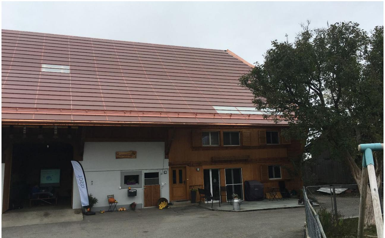
Légende : Ferme à Ecuvillens, site d'importance régionale dans un périmètre construit à protéger de catégorie 2 au sens du plan directeur cantonal, projet pilote avec la pose de panneaux solaires de couleur rouge terre cuite sur une toiture de ferme dans un contexte protégé. © SBC/KGA
